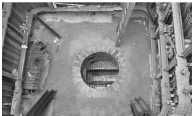
Obrázek č. 16 – Výstavba revizní kanalizační šachty v těžní šachtě
