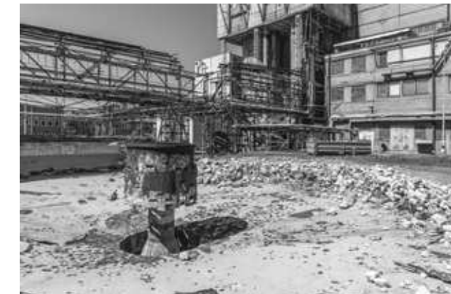
Likvidace zahušťovací nádrže na Chemické úpravně v Dolní Rožince
