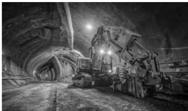
Obrázek č. 11: Doukolejný tunel s rozšířením
