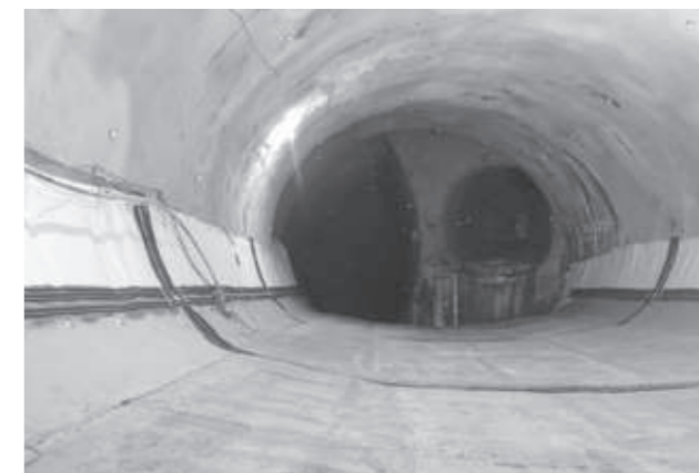
Obrázek č.7: Instalace hydroizolačního souvrství v obratových kolejích včetně ochranné betonové mazaniny.
