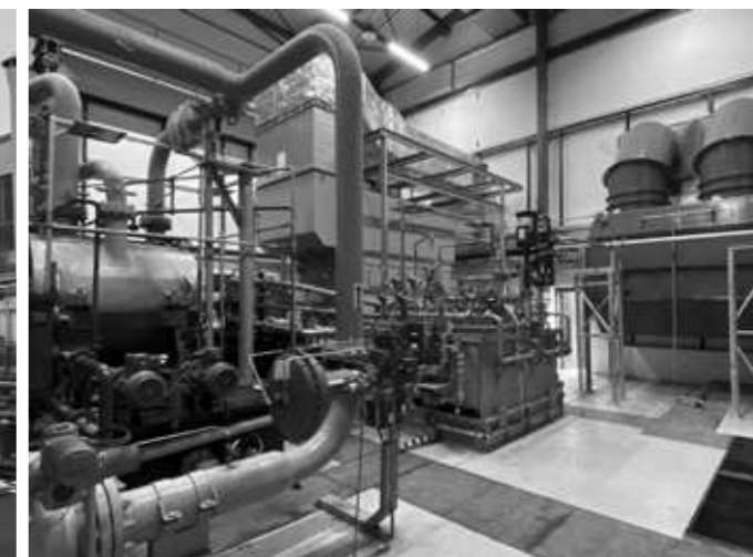
Pohon kompresoru na PZP Štramberk
