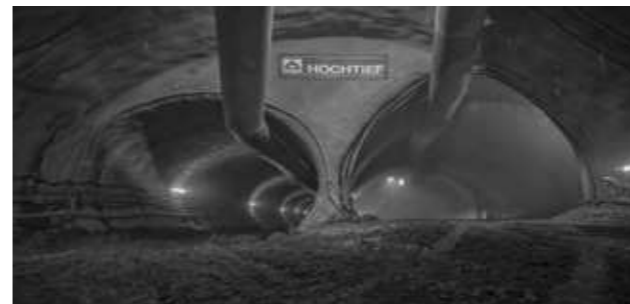
Obrázek č. 13: Rozplet do jednotlivých tunelů
