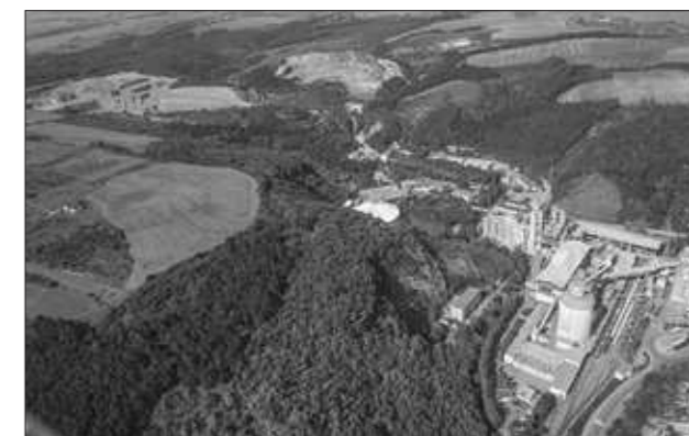
Lomy a cementárna Radotín
