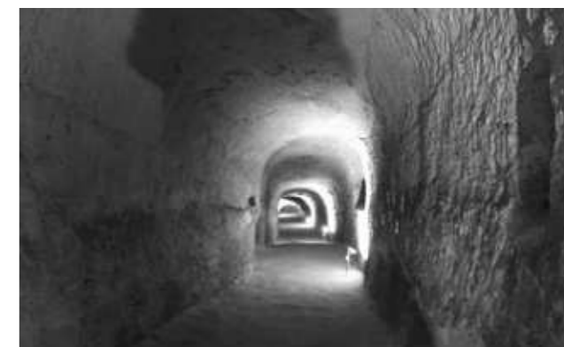
Obr. č. 6: Podzemí kaolinového dolu Nevřeň
