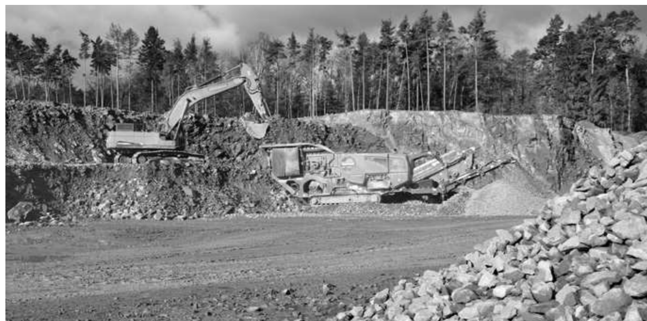
Nakládka rubaniny do mobilního čelistového drtiče
