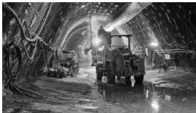
Obrázek č. 9: Vrtání vrtů pro chemickou injektáž z patní štoly
