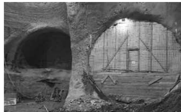
Obrázek č. 21 - Pohled na kalotu ETS (vlevo LST střední profil)
