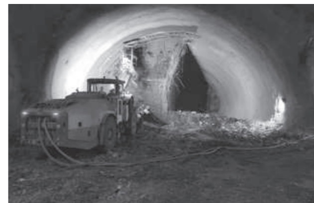
Obrázek č.5: Ražba levého dílčího výrubu kaloty směrem k demontážní komoře
