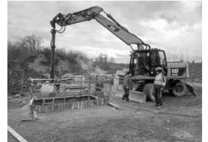
Hloubení šachty, Cukrovar Modřany, Praha
