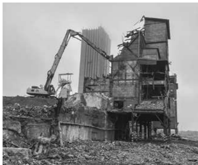
Demolice úpravny Dolu Lazy
