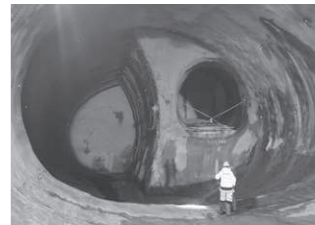
Obrázek č.6: Ukončená ražba obratových kolejí směr Pankrác. Vpravo štola do úrovně kaloty stanice Pankrác
