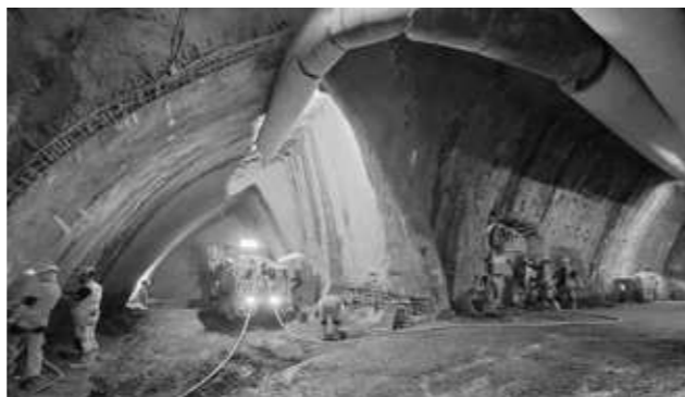
Obrázek č. 10: Začátek ražby kaloty a dna kaloty pravého dílčího výrubu stanice Pankrác
