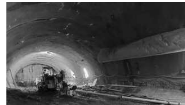
Obrázek č. 23 - Pohled na kalotu LST směr Krč
