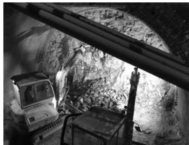
Obrázek č. 26 - Pohled z výtahové šachty Š2.2 směr ke střední lodi stanice JzP
