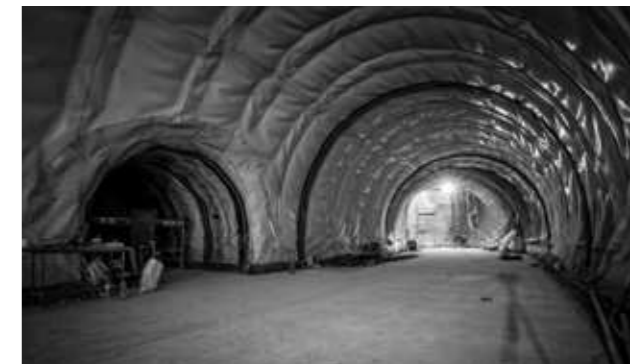
Obrázek č. 14: Hydroizolační souvrství
