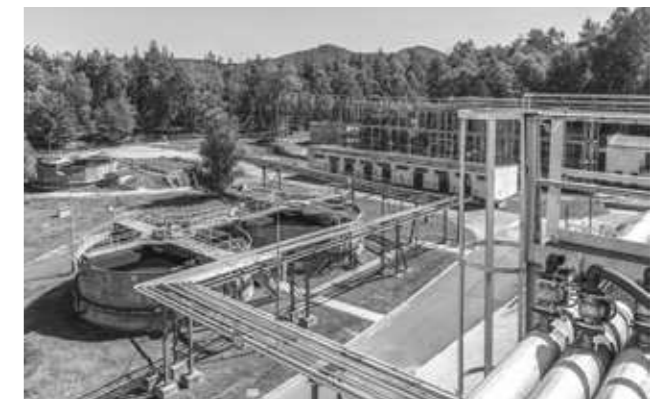
Technologie Chemické stanice I v areálu Dolu chemické těžby
