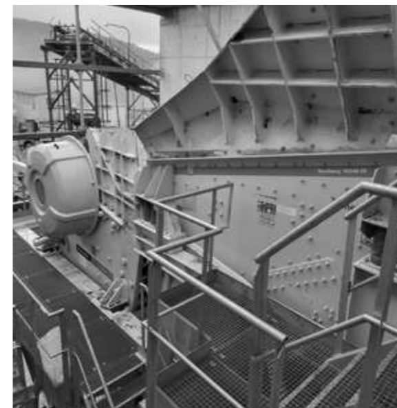
Montáž primárního uzlu linky v kamenolomu VEČEC, Slovensko
