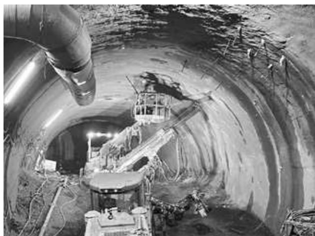
Obrázek č. 25 - Realizace kompenzačních injektáží
