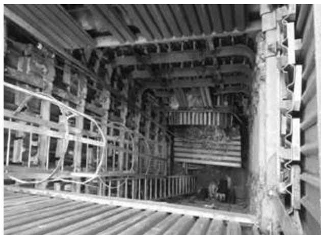
Obrázek č. 17 – Těžní šachta s rozrážkou
