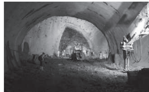
Obrázek č.4: Ražba pravého dílčího výrubu kaloty směrem k demontážní komoře
