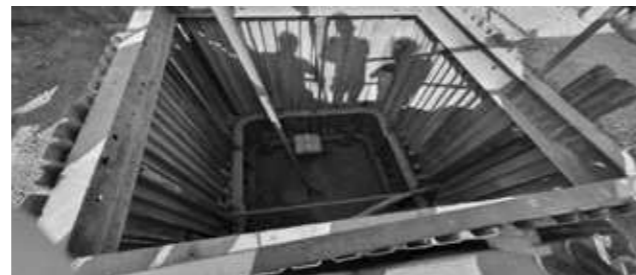
Obrázek č. 18 – Zalévání popílčkem uliční vpusti
