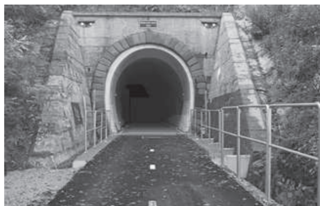
Původní železniční tunel z roku 1913 přebudovaný jako součást cyklotrasy Rimavská Sobota-Poltár.
