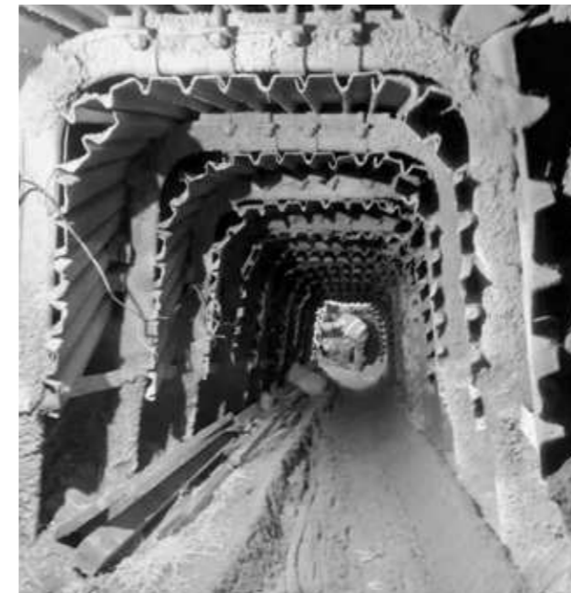
Ražba štol pro kanalizaci, Cukrovar Modřany, Praha
