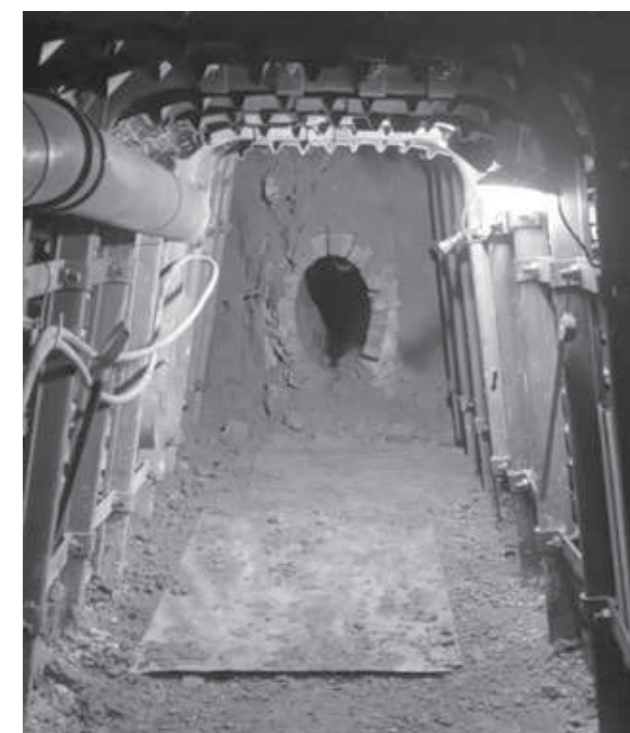
Přehled staveb realizovaných v roce 2023, prováděných hornickým způsobem
