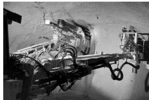
Obrázek č. 20 - Vrtání mikro-pilotového deštíku
