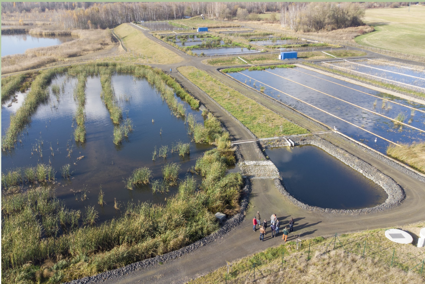
Obr. č. 5: Nádrž D (vlevo) a nádrže C (vpravo)
