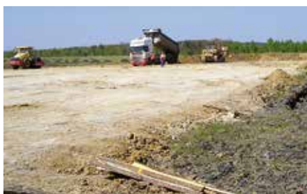
Obr. č. 6: Postup sanací na kalojemu K IV/D v r. 2009
