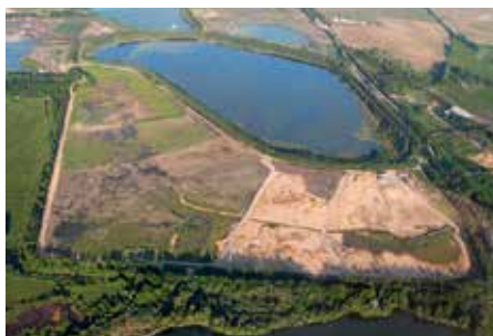
Obr. č. 8: Postup sanací na kalojemu K IV/D v polovině r. 2010
