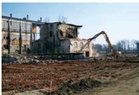
Obr. č. 4: Likvidace tzv. výrobního bloku MAPE
