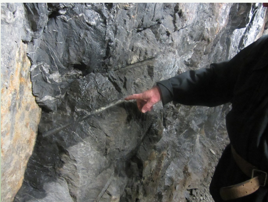
Obr 4: Ruční obrysový vrty v levém boku mihadlové chodby ukazují na délku a průměr tehdejších vrtů. Foto J. Jiskra
