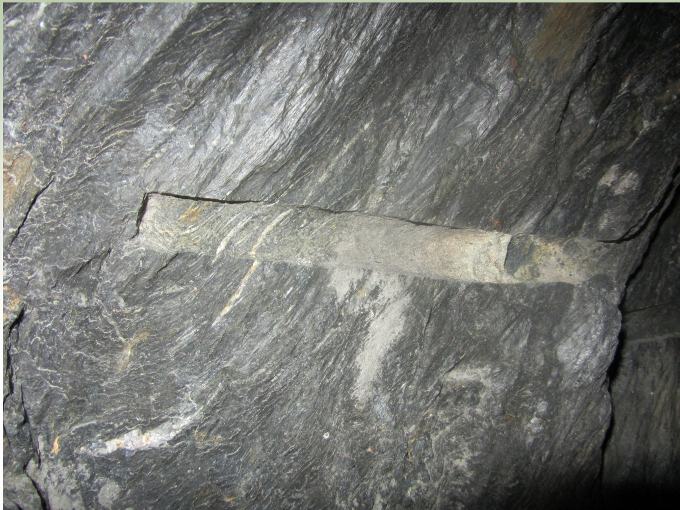
Obr 3: Historický obrysový vrt po odstřelu s ucpávkou.
