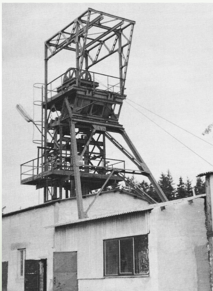
Obrázek č. 1: Těžní věž průzkumné šachtice Š-56 Licoměřice
